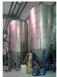
B2 Fermentations-tanks in einer Brauerei
