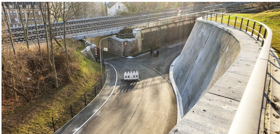
Die Stützmauer an der Bergstraße | Fotos auf dieser Seite: K. Grebasch, STV Zittau
