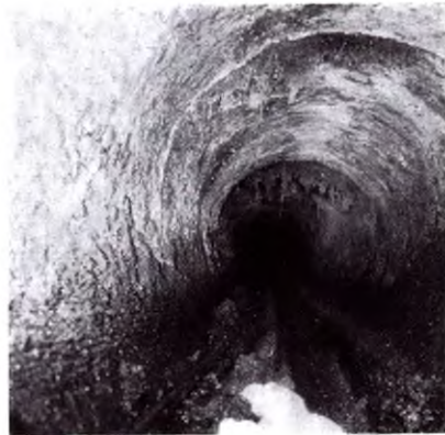
Inneres einer Rohrleitung
