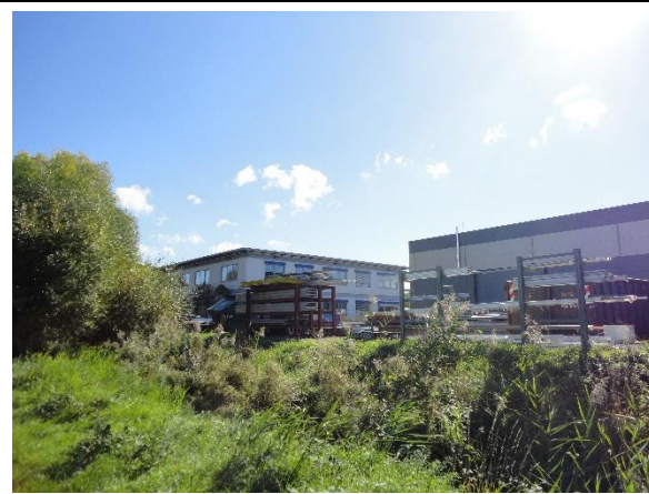
Foto 5: Bebauung am nördlichen Wirtschaftsweg
