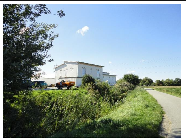
Foto 6: Bebauung am nördlichen Wirtschaftsweg
