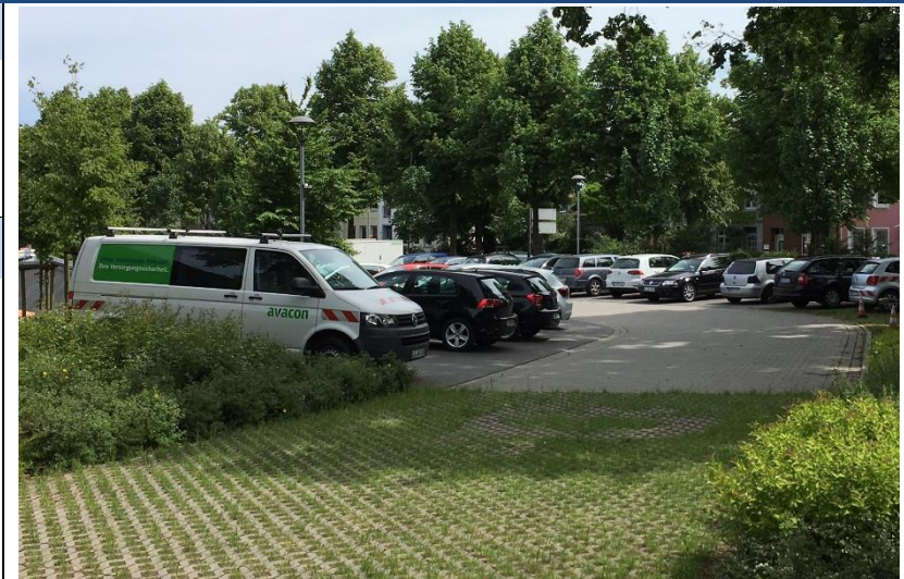
Bild: Rasengittersteine, Parkplatz in Lüneburg (Quelle: E. Hipler, GEO-NET)
